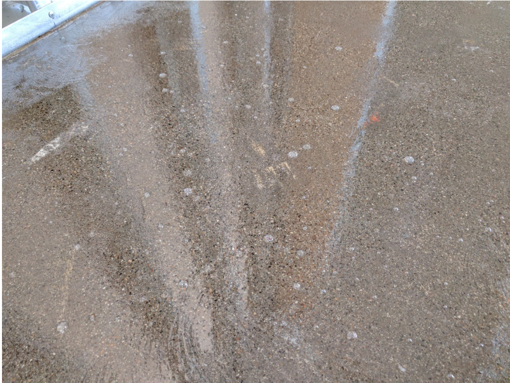
49. Air bubbles in cured primer (03/12/2017).
