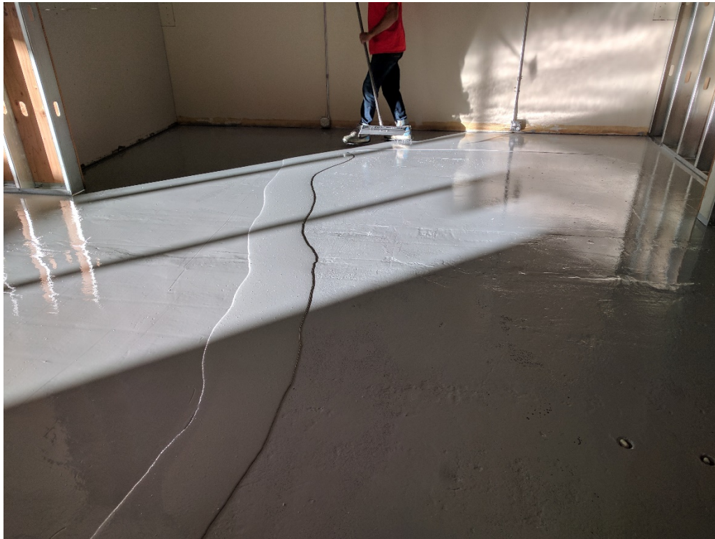
83. Representative ribbon pour of Retro-coat Core layer 2 (03/13/2017)
