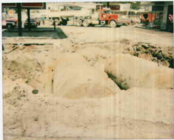
7.5K tank puller, 240K placement 9/14/91 EXAM 2200 E122E
