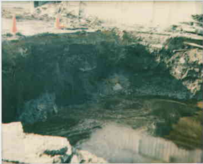
12/21/92 D3216211255-8 566 Heggenburger Rd Anco. FP - tank pit
