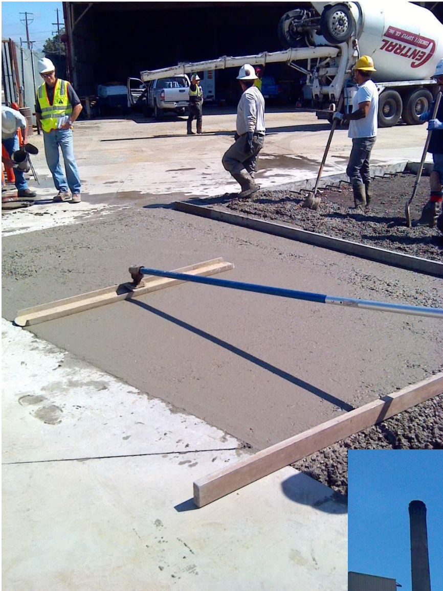
Figure 45: Concrete Pour @ Ex E
