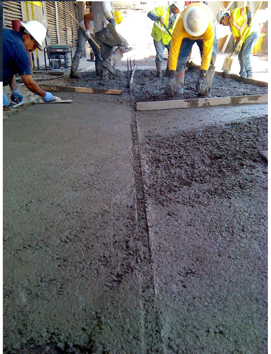
Figure 19: Concrete Pour @ Ex C
