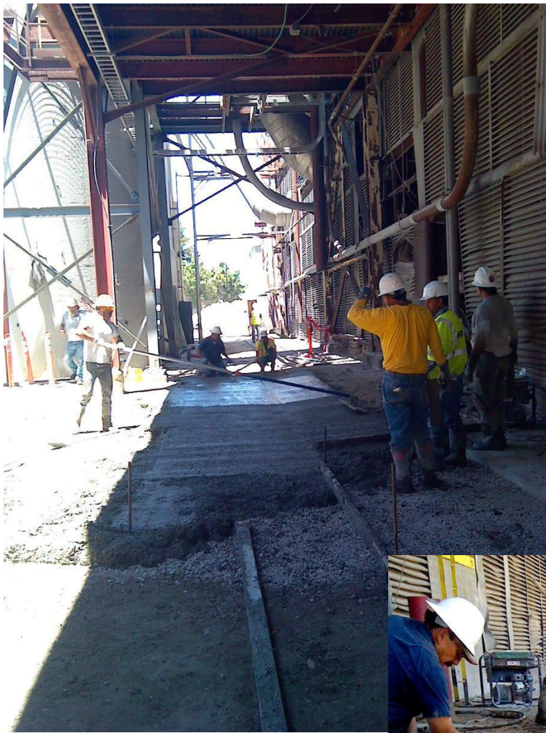
Figure 18: Concrete Pour @ Ex C
